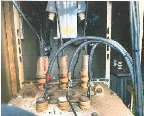
LBS下部 ヒューズの破片が散乱し、ケー ブル等が焦げている ただし、各種試験の結果異常なし
