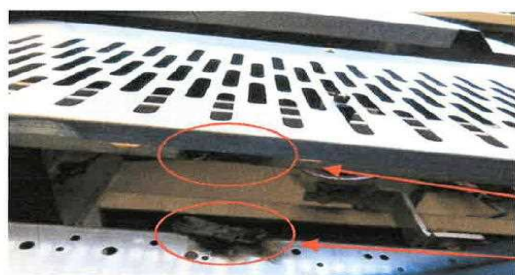
金属板の裏側の様子(下方から)
