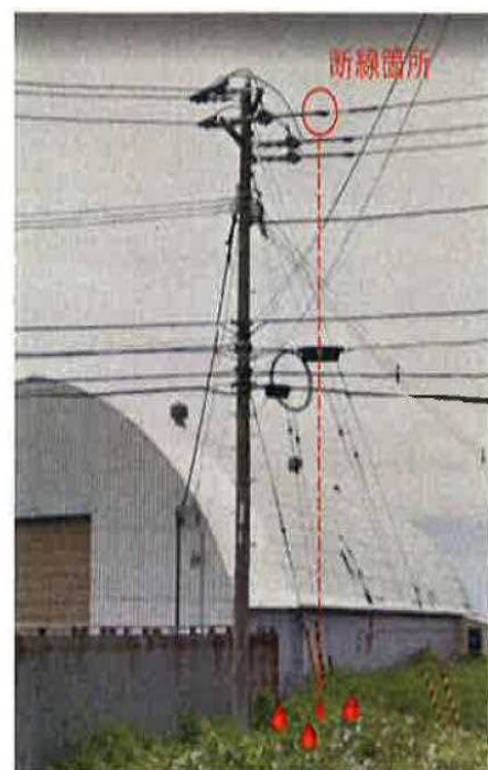
分岐スリーブカバーが滴下し、野火が発生
